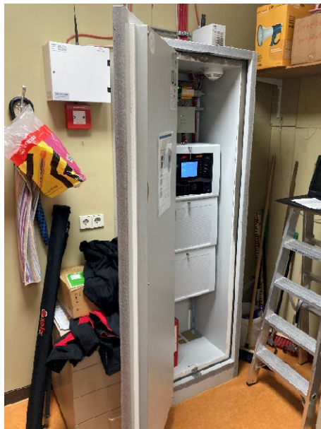
Bild 13 und 14: Brandmeldezentrale und Einbruchmeldezentrale im EG-Hausmeisterraum 108
