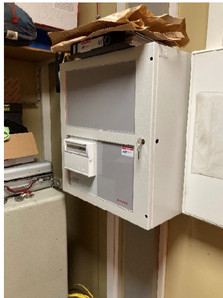
Bild 13 und 14: Brandmeldezentrale und Einbruchmeldezentrale im EG-Hausmeisterraum 108
