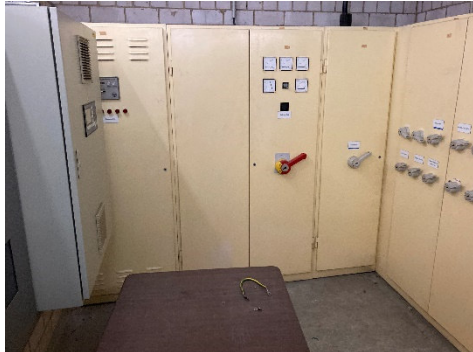
Bild 1 und 2: NSHV, Kompensationsanlage mit Messeinrichtung
